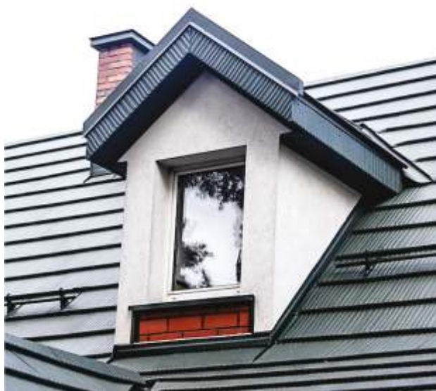
Schemat - wiatrownica górna
