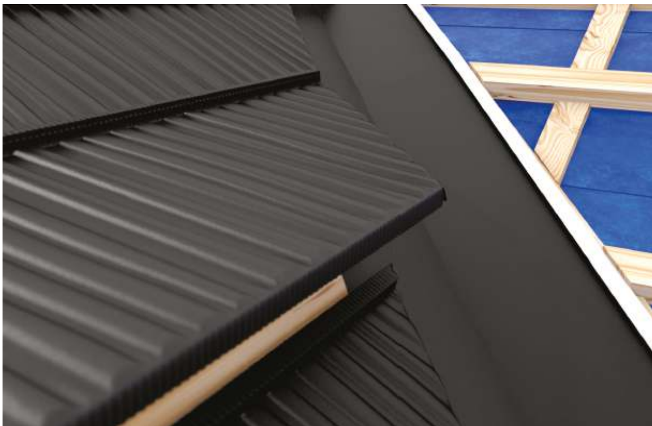
Montaż paneli w rynnie koszowej.
