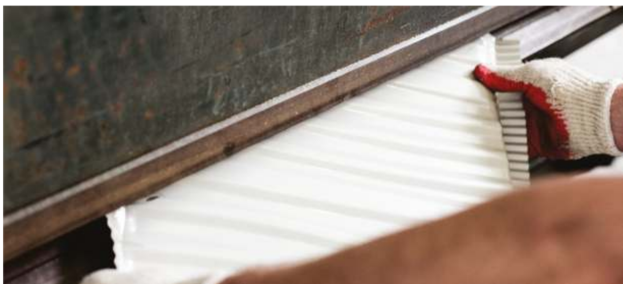
Panele przed montażem wymagają „zamknięcia” poprzez podgięcie ich bocznej części znajdującej się w rynnie.
