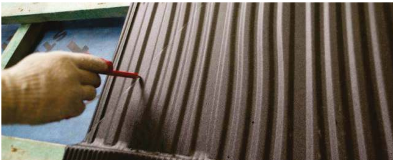
Zaznaczanie linii cięcia ołówkiem.
