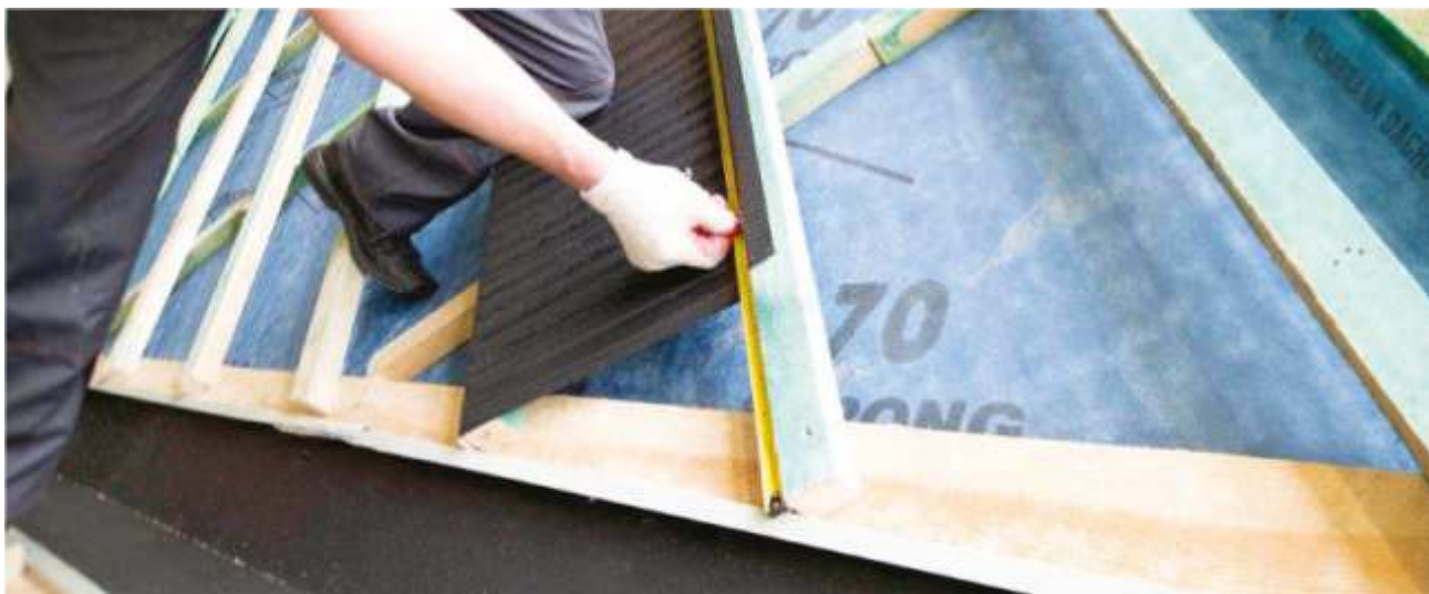
Wykonywanie pomiarów konstrukcji w celu docięcia paneli koszowych.
