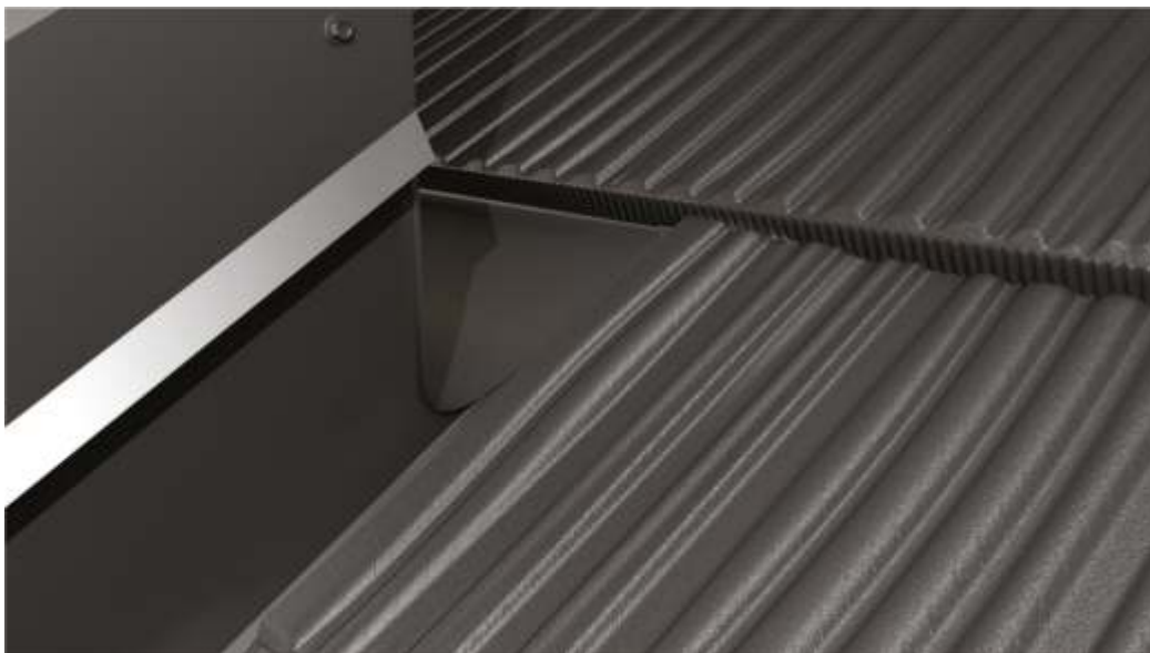
Tylna część obróbki komina po montażu paneli.
