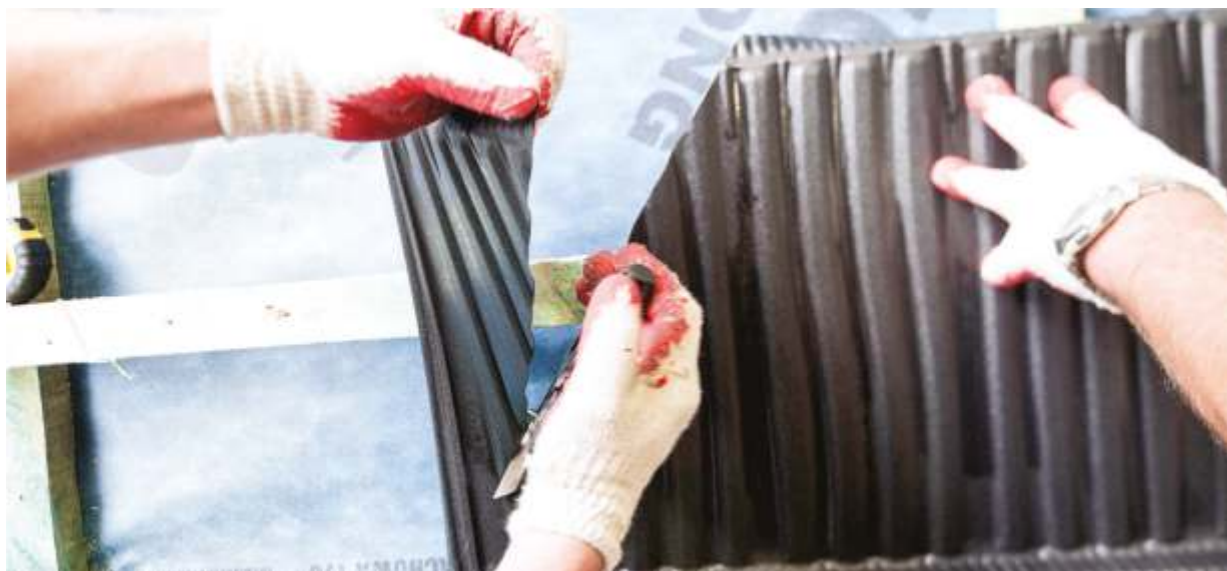
Odcinanie niepotrzebnej części panelu.
