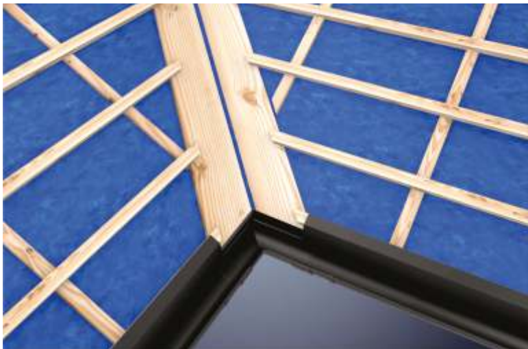
Konstrukcja pod rynnę koszową.
