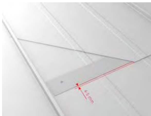
Rys.17 Połączenie paneli na obcę listwę.
