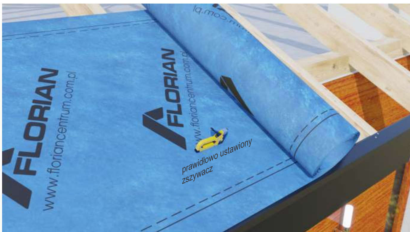
Układanie membrany.
