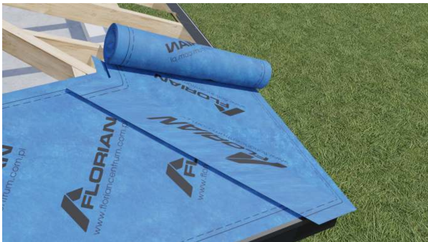
Łączenie membran w narożniku.
