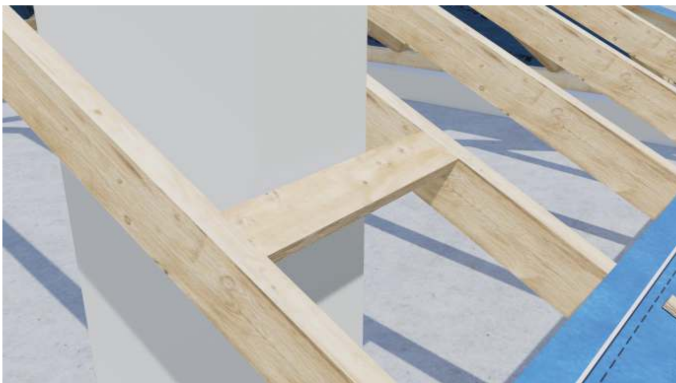
Montaż dodatkowej deski pod kominem.
