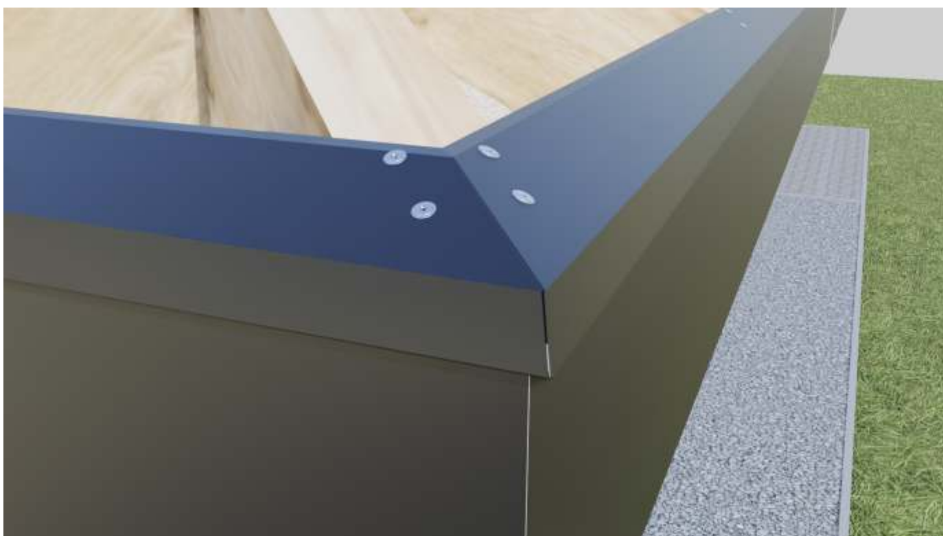
Łączenie obróbek okapu na zakładkę w narożniku.
