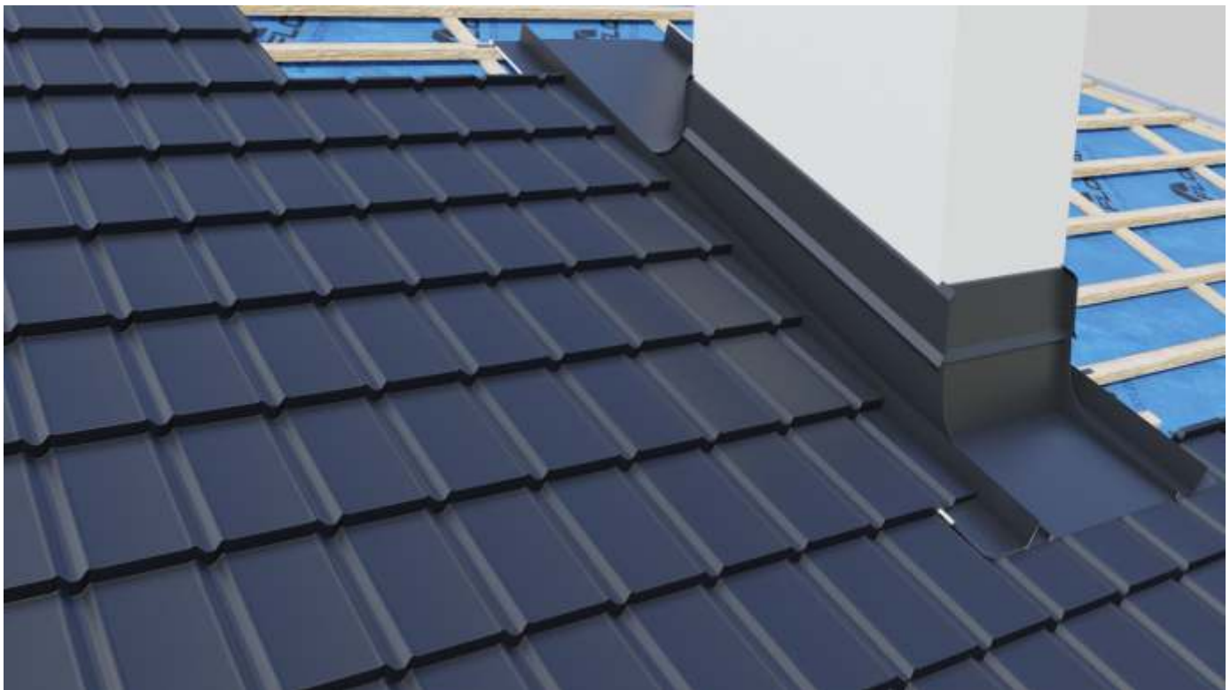
Panele zamontowane wzdłuż obróbki.
