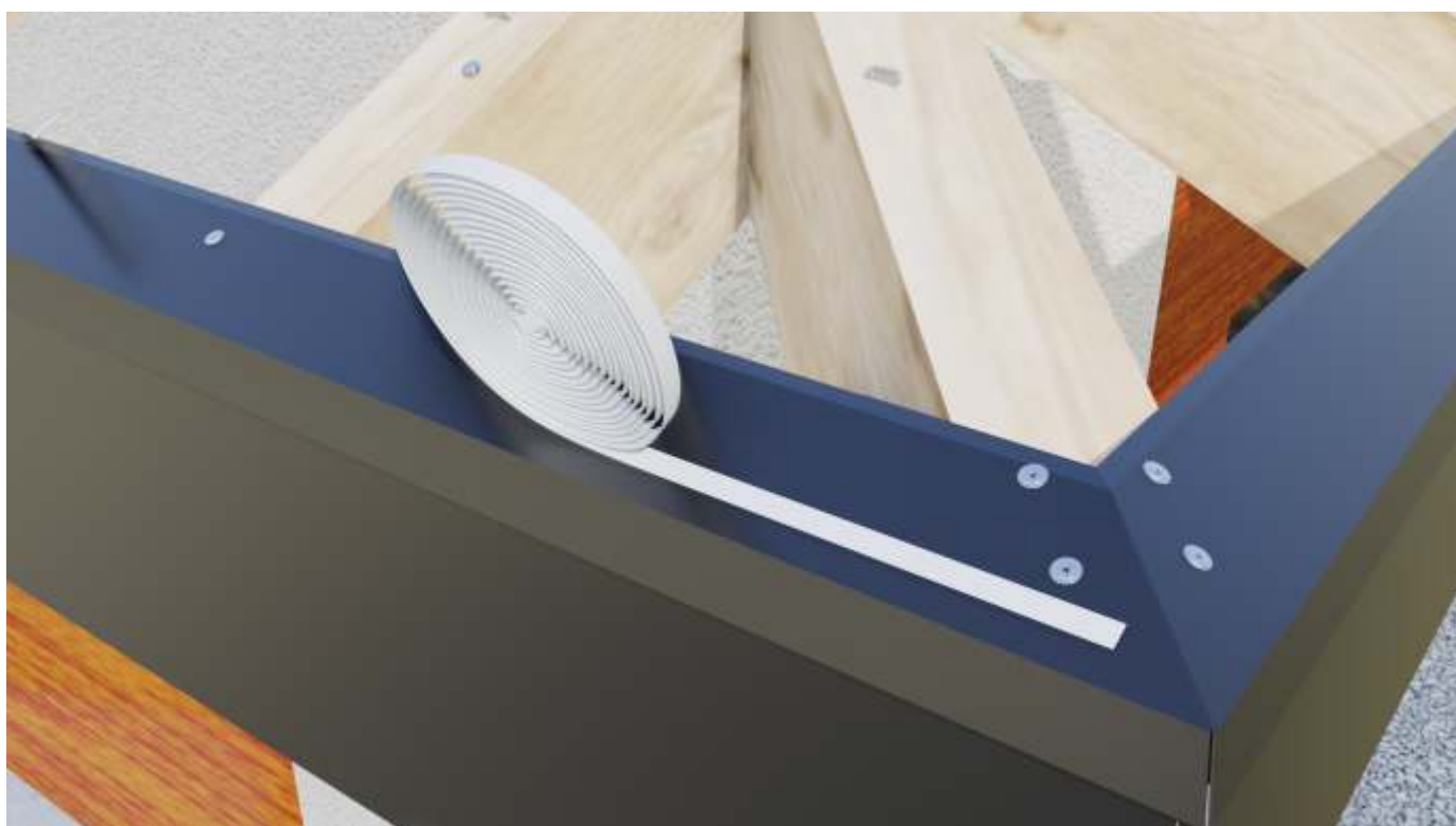
Klejenie taśmy dwustronnej na obróbkach.
