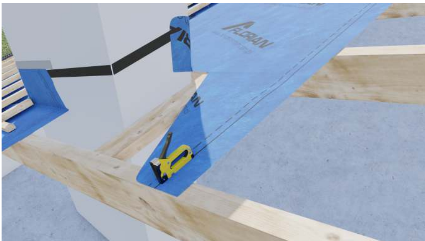
Mocowanie membrany do krokwii za pomocą zszywek.
